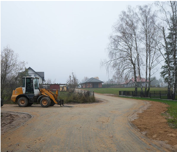
Remont ulicy Nagietkowej
