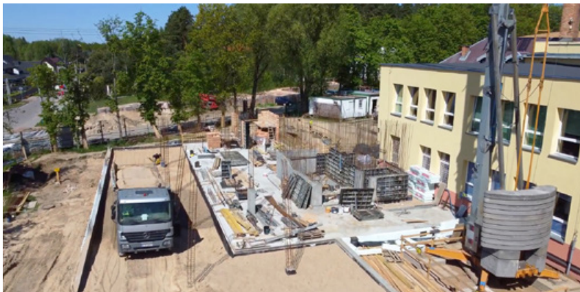
Remont szkoły w Sobolewie [fot. UM Supraśl]
