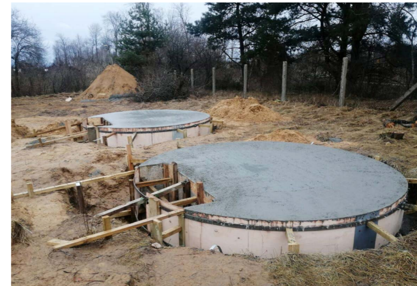
Budowy stacji uzdatniania wody w Szymkach
